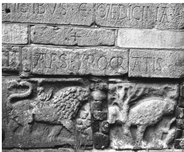
72. Blocs de réemploi en soubassement, cathédrale du Puy.
